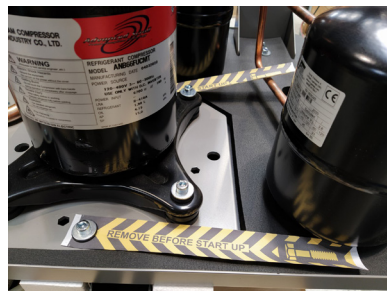
Ilustracija 5.1 Apsauginių transportavimo elementų nuėmimas
