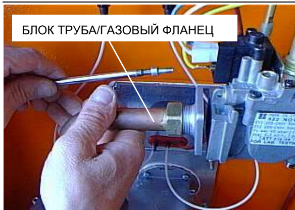
Рисунок 35 – Блок труба/газовый фланец
