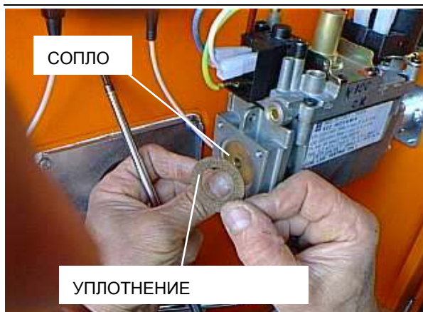
Рисунок 37 – Замена сопла
